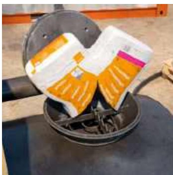
Figur 1 Tilføj fermacell bikubegranulat. (Se 0,17 sek. i montagevideoen.)
