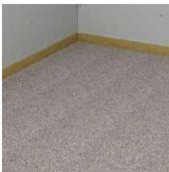
7 Her ses det færdige resultat. Helt plan opretning med fermacell™ Niveaumørtel T.
