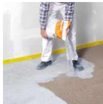
Udhældning af fermacell™ Bikubegranulat
