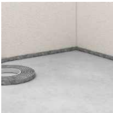
Anbringelse af kantisolering
