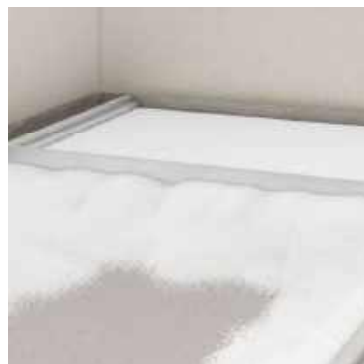
udhældning og afretning af fermacell™ Niveaugranulat
