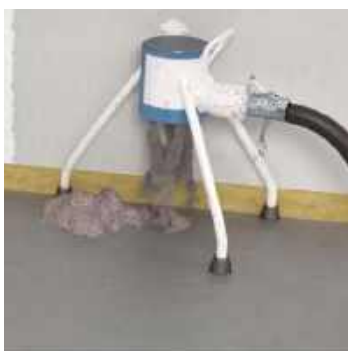
Figur 4 Udlægning af færdigblandet trinlydsgranulat. (Se 0,37 i montagevideoen.)
