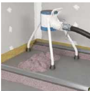
Figur 5 Evt. nivellering af dæmninger, vent indtil dæmningerne er tørret. ca. 20 minutter. Herefter udfyldes med fermacell trinlydsgranulat. (Se 0,49 sek. i montagevideoen)
