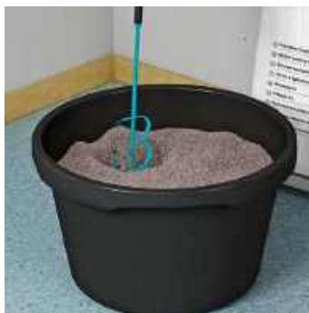
2 ... derefter blandes med en egnet blander/pisker, til niveaumørtelen har en konsistens som fugtig jord.
