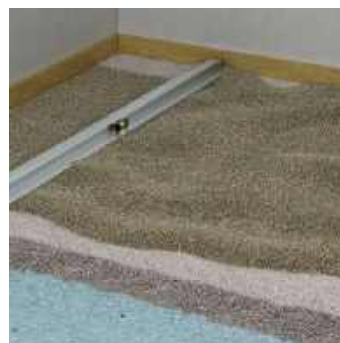
6 Når niveaumørtelen er lagt i mellem dæmningerne, jævnes der ud.
