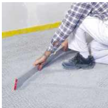
Afretning af fermacell™ Bikubegranulat
