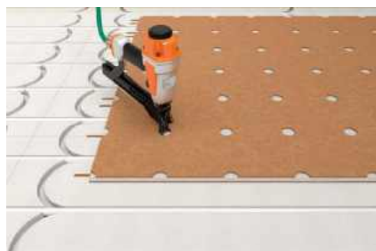
Montage af øverste lag fibergips og mekanisk fastgørelse ved hjælp af skrues eller klammer ved anvendelse af skabelonen.
