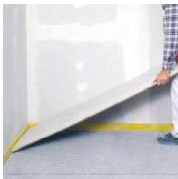
Udlægning af fermacell® Fibergips gulvelement
