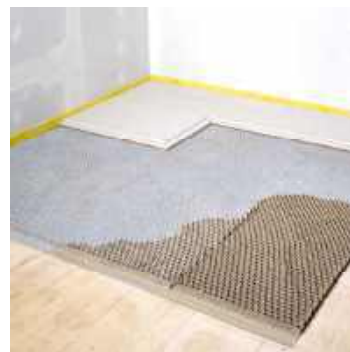
Princip for udlægning af gulvelementer på bikubesystemet
