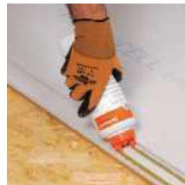
fermacell™ Fibergips gulvelementlim påføres i falsen
