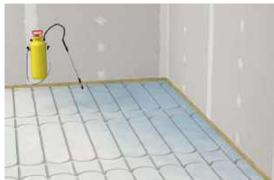
Grunding af fermacell® Therm25™ gulvarmeelementerne med fermacell™ universalgrunder eller tilsvarende.
