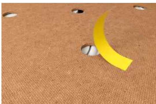
Placering af skabelonen hvor øverste lag fibergips skal ligge. Kontrol af, om varmerør befinder sig under fastgørelsespunkterne. Hvis dette er tilfældet, skal fastgørelsespunktet dækkes af med tape.
