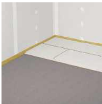
8 Udlægning af gulvelementer efter ca. 24 timer
