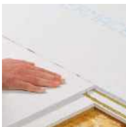
Limning af gulvelementerne med helt fyldte stødsamlinger
