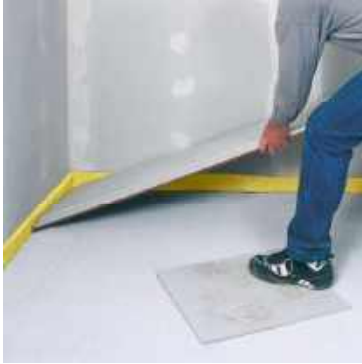
Udlægning af fermacell® Fibergips gulvelementer på fermacell™ Niveaugranulat
