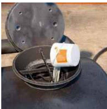
Figur 2 Tilføj fermacell binder. (Se 0,23 sek. i montagevideoen.)
