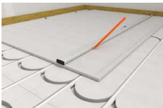
Opstregning af fastgørelsespunkter og -akser. Markering af fastgørelsespunkterne.
