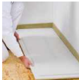
Montage af fermacell® Gulvelementer
