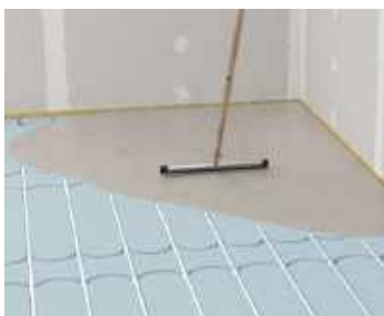
Spartling af Therm25™ gulvvarmeelementerne med fx fermacell™ klæbemørtel
