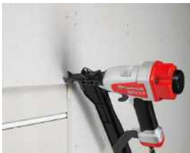
Fastgørelse af et yderligere lag fermacell® Fibergips.
