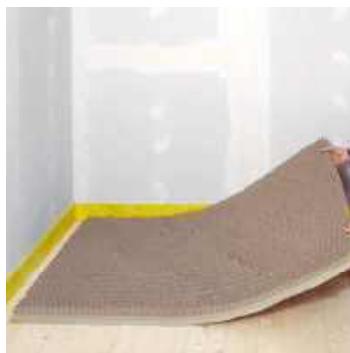
Udlægning af fermacell™ Bikubeunderlag
