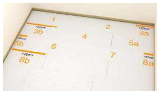
Montageskema 1 – udlægning mod dør
